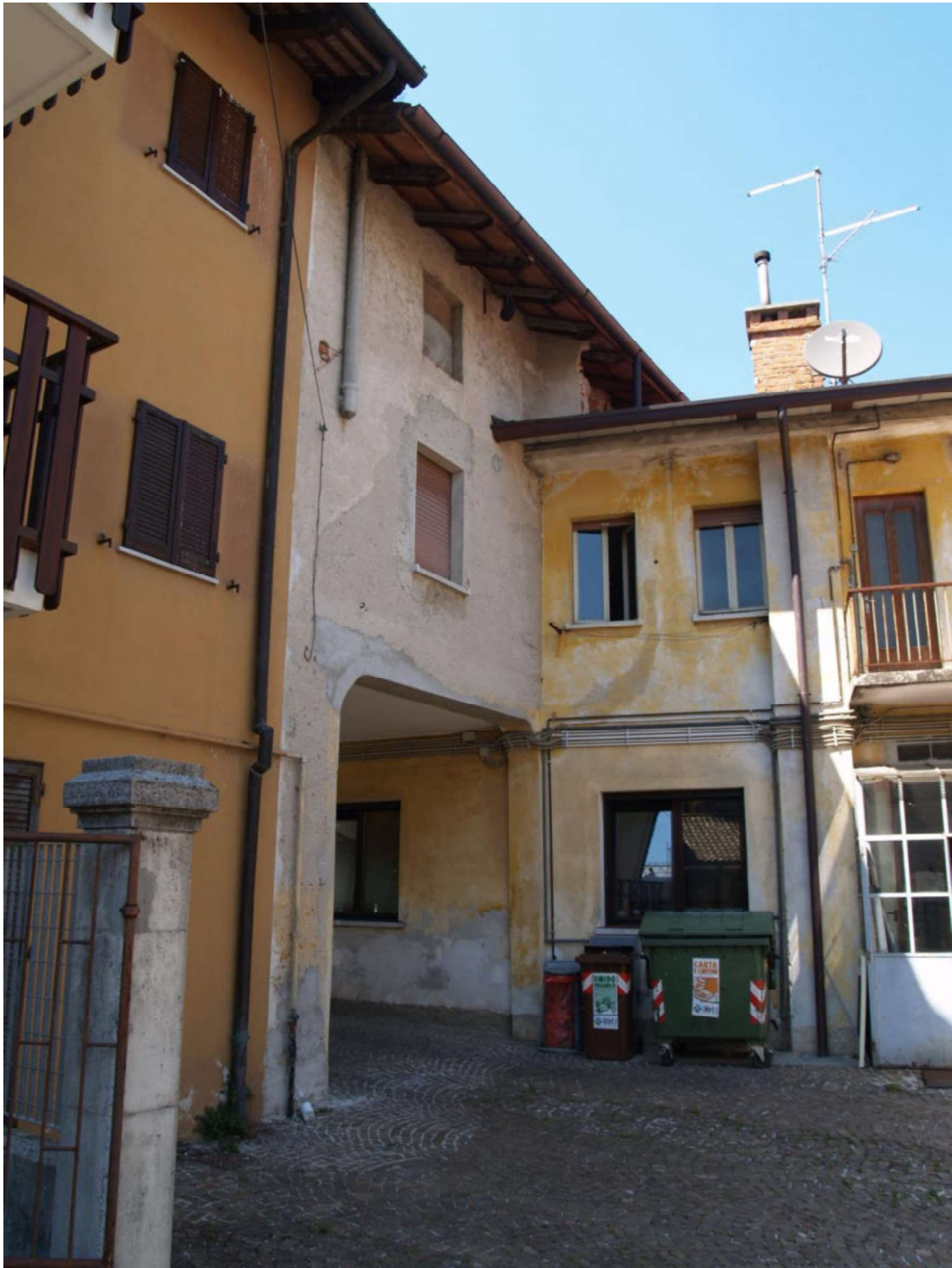
PORTICATO NORD VISTO DALLA CORTE INTERNA
