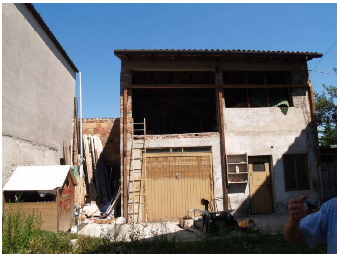
CORTE INTERNA VISTA SULL'ACCESSORIO DELLA PARTICELLA 365
