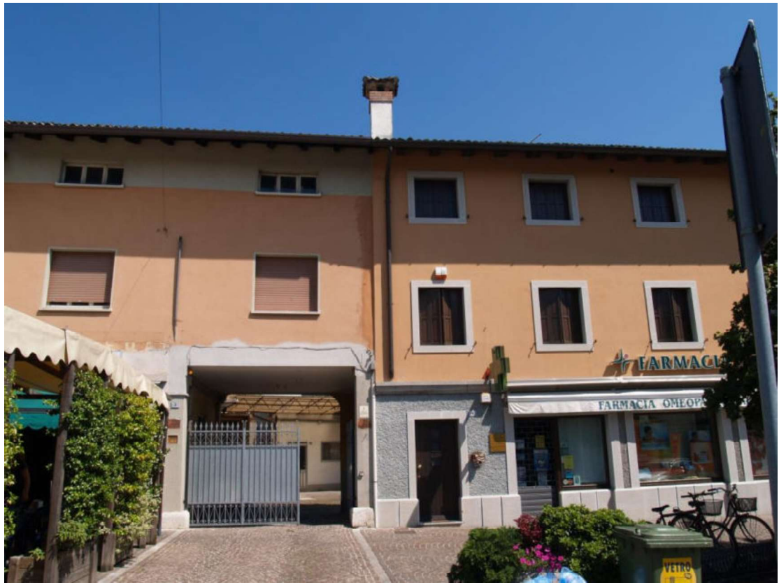
VISTA DA PIAZZA MATTEOTTI
