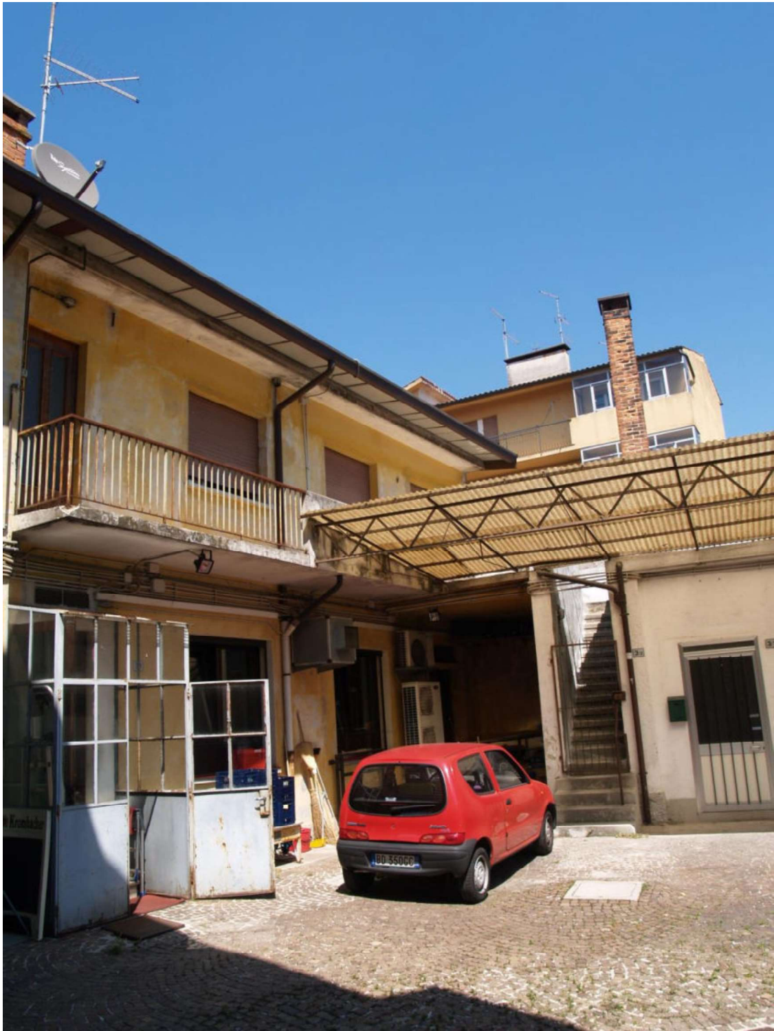
CORTE INTERNA ACCESSORI PARTICELLA 574
